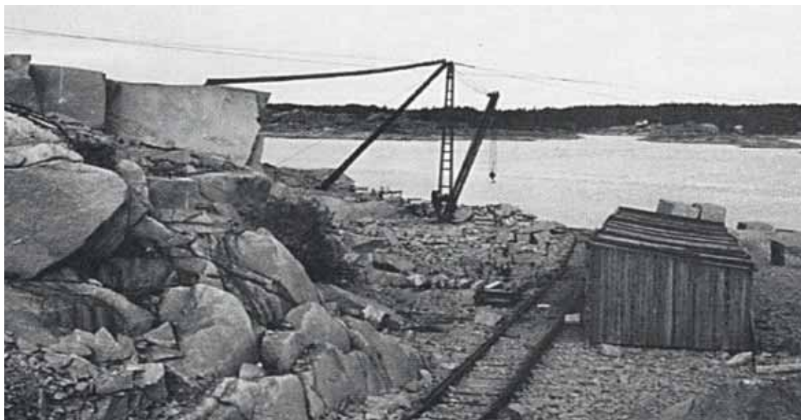
Kran og jernbaneskinner på Store Råholmen. (1940-tallet)
