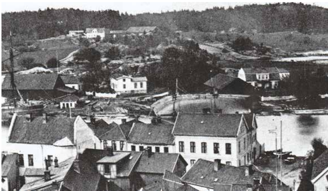
Fredrikstad Mekaniske Verksted 1870-årene. Sett fra Fredrikstad mot Åsgård.
