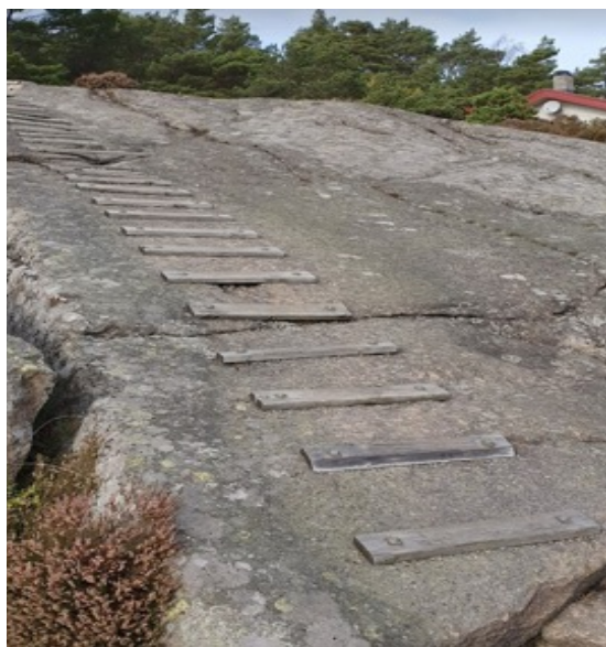
Trinn festet i fjellet for å bedre fram-kommeligheten på kyststien.
