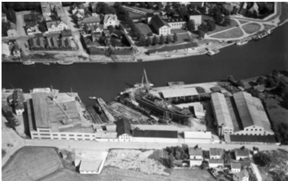
Bilde av området i 1951, mens det var en betydelig skipsbygging, og seks år før Kråkerøybroen ble bygget. (Foto: Ukjent)
